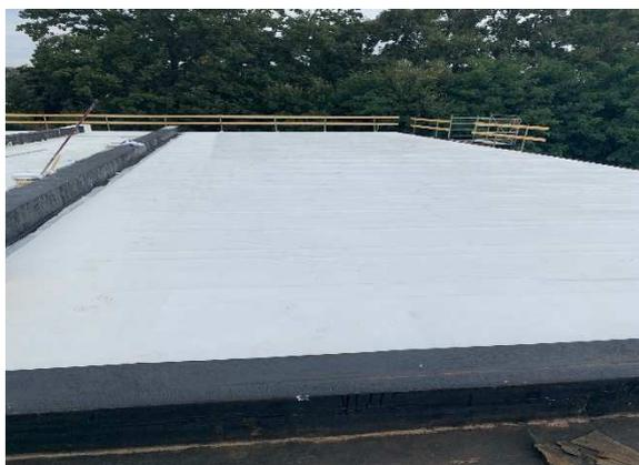
In particolare si interverrà creando uno strato di protezione delle guaine bituminose faccia vista, migliorandone la funzionalità e la durabilità. Inoltre lo strato di protezione che verrà applicato avrà un indice di riflettanza solare che contribuirà in buona parte ad abbassare anche la temperatura di esercizio dei tetti, migliorando il benessere degli alunni nelle aule.
